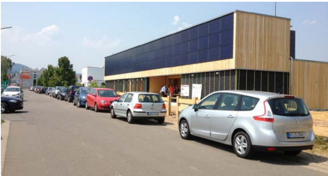
Abb. 22: Fassaden- integrierte PV-Anlage am Gebäude der Georg-von- Neumayer- Stiftung der Pollichia e.V. (Quelle: Solar-Info- Zentrum SIZ GmbH).
